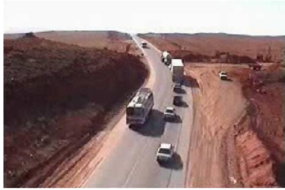
شکل ۱ وضعیت تردد در محل پیچ عباس آباد قبل از آغاز بهسازی
