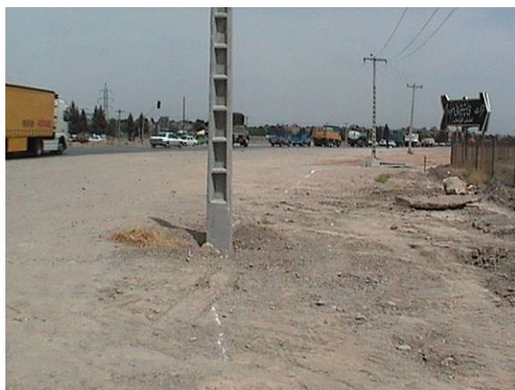
شکل ۹ آغاز اقدامات بهسازی برای احداث تقاطع غیر همسطح سردخانه
