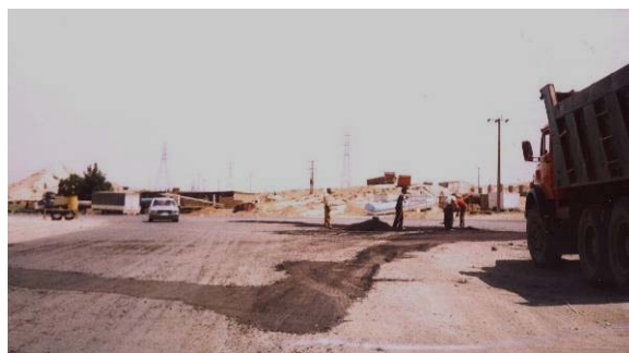
شکل ۱۱ وضع نامناسب روسازی معبر در محل تقاطع سد طرق
