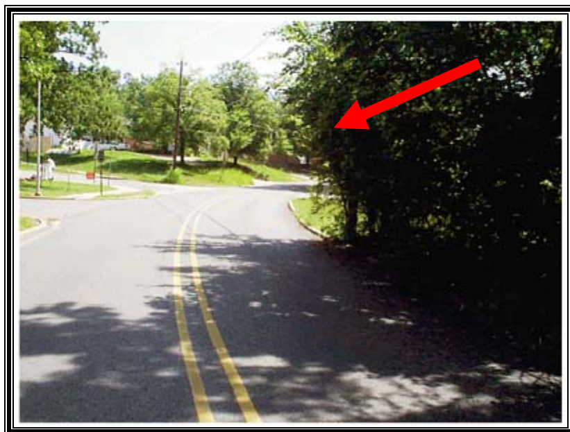
شکل ۲- ممانعت دید تابلو در اثر رشد شاخ و برگ درختان قبل از پیچ
